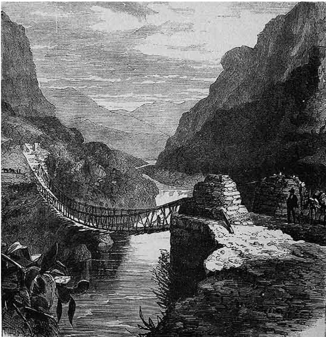
Puente sobre el río Pampas (o Vilcas, en Ayacucho). Squier, 1864
