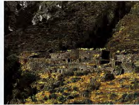
9. Vista de la arquitectura del sector central de Caniche.
